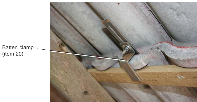
Fig. 13 - Batten clamp
